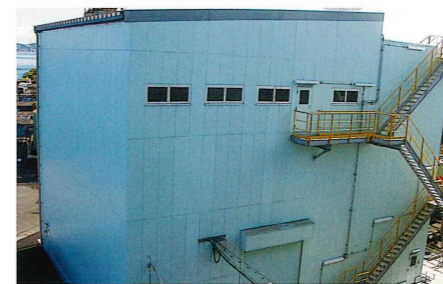
低濃度PCB前 処理設備 (大型品受入倉庫)
