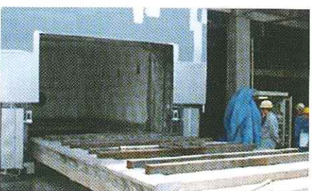
固定床炉 (産廃処理、 低濃度PCB処理)
